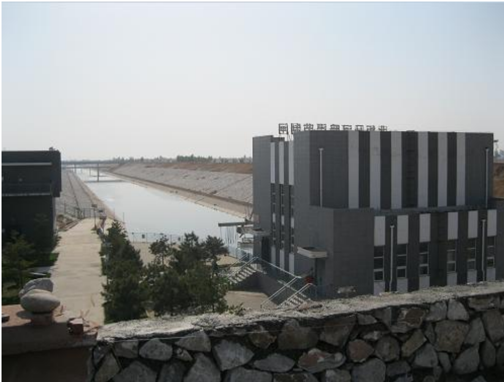
Figure 4 Le canal qui convoie les eaux de la rivière Beijuma vers la station de pompage de Huinanzhuang (site visité par la délégation française de haut niveau en Octobre 2013)
