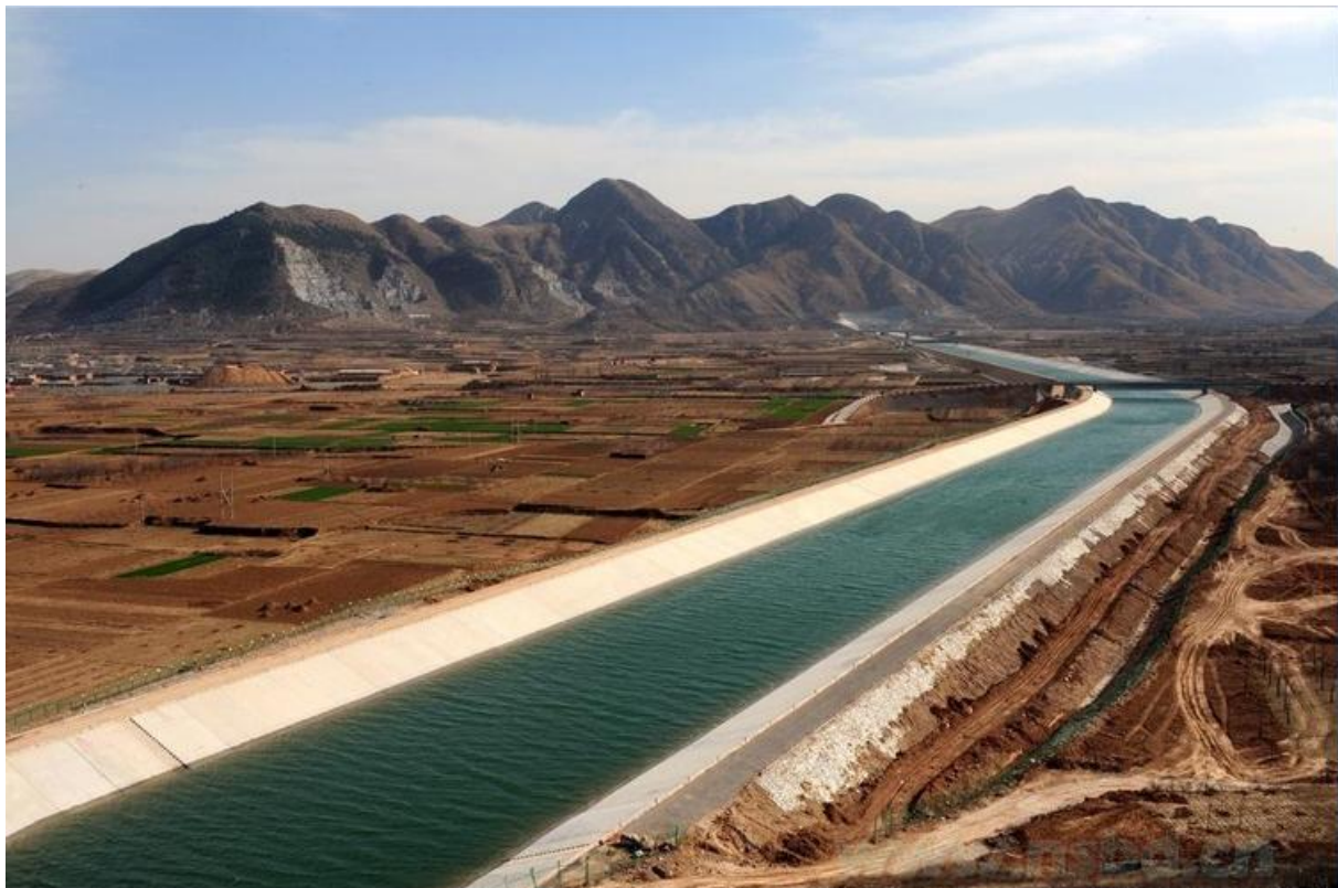
Figure 3 L'un des canaux à ciel ouvert du projet de transfert Sud-Nord ( http://www1.american.edu/ted/ICE/north-china.html )
